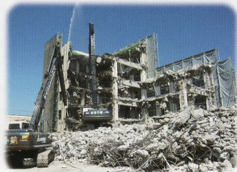
旧病院棟解体
